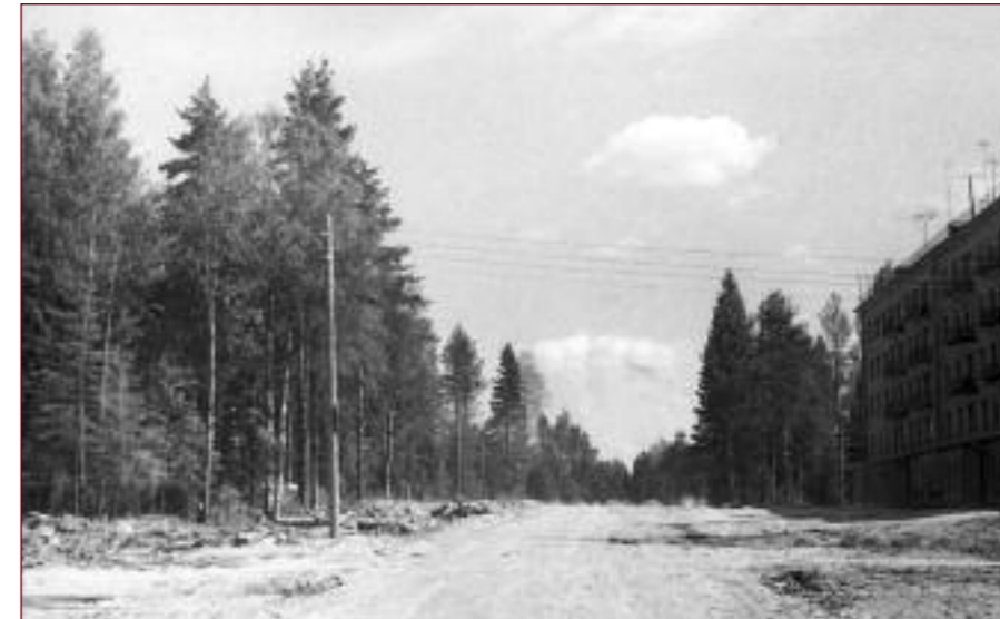
Под Дом офицеров еще только роется котлован...
